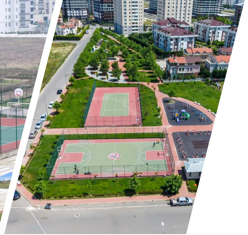
Hürriyet Mahallesi Nazım Hikmet Ran Parkı Basketbol Sahası ve Tenis Kortu
