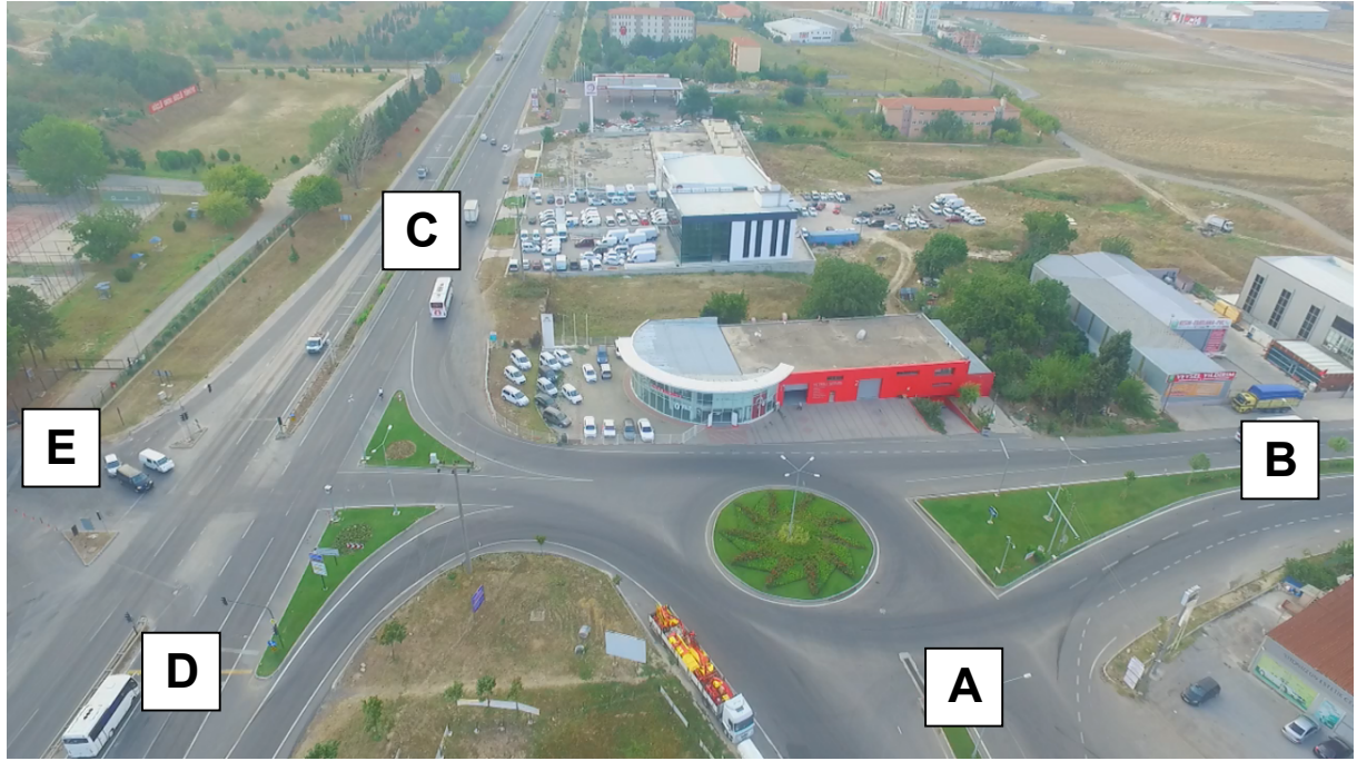
Şekil 2.17. ÇK15 Kavşağı görüntüsü ve kollar
