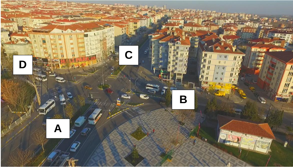
Şekil 1.23. 21 No'lu kavşak İHA görüntüsü ve kollar
