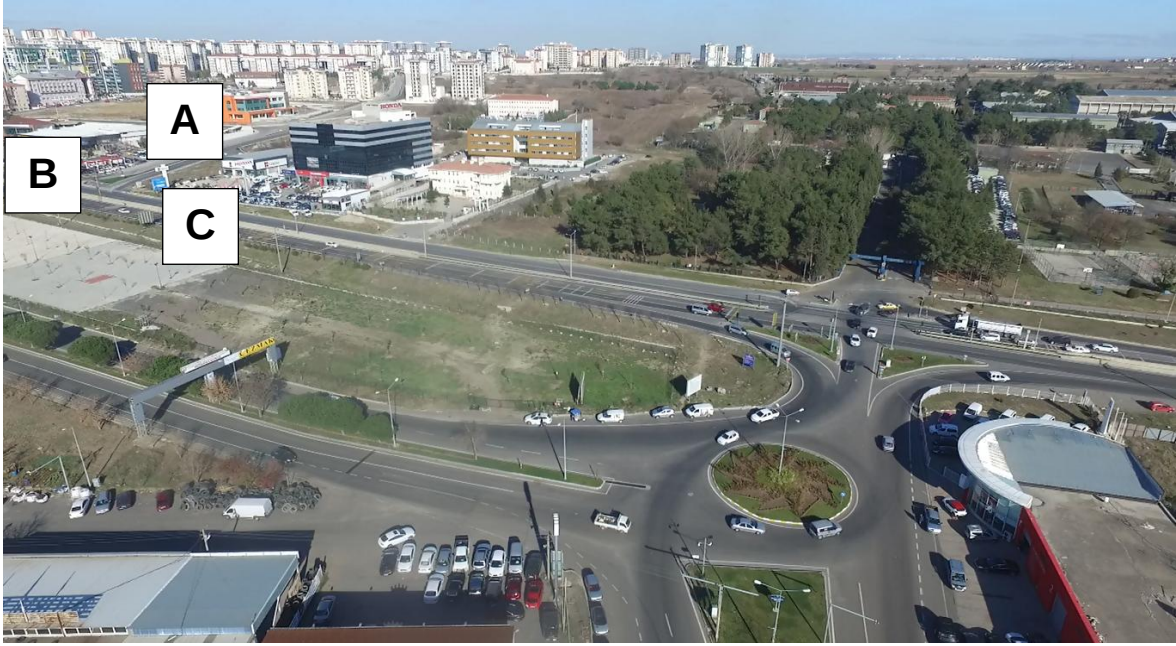
Şekil 1.6. 5-1 No'lu kavşak İHA görüntüsü ve kollar
