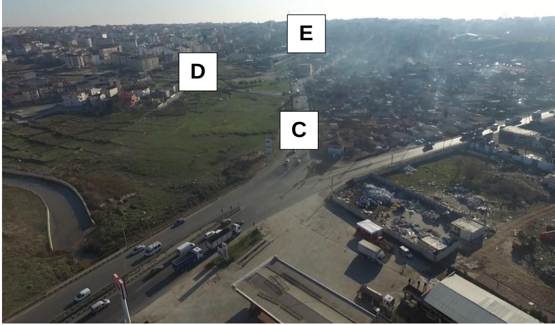
Şekil 1.20. 17-2 No'lu kavşak İHA görüntüsü ve kollar
