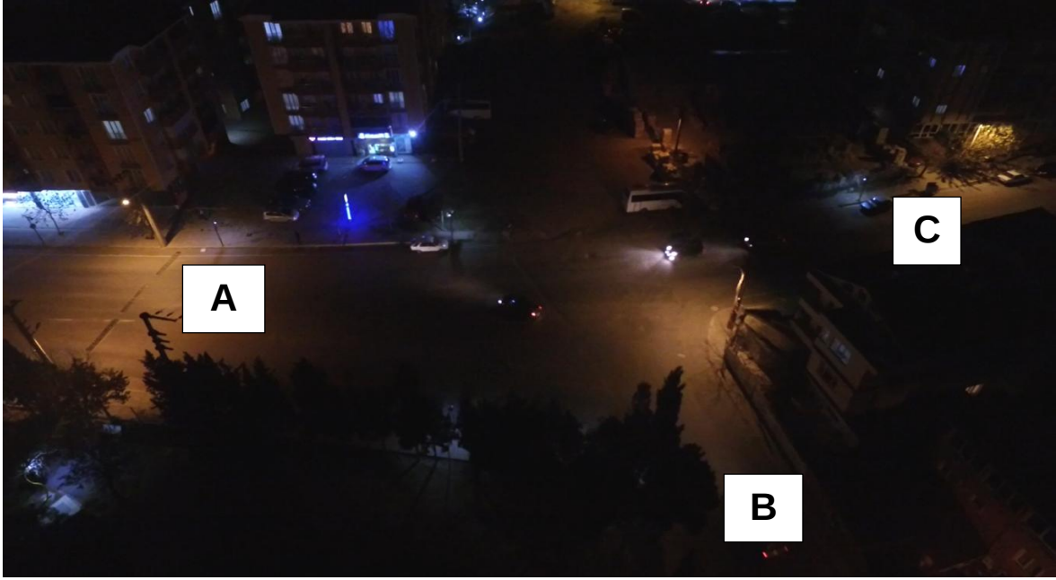
Şekil 1.25. 24 No'lu kavşak İHA görüntüsü ve kollar
