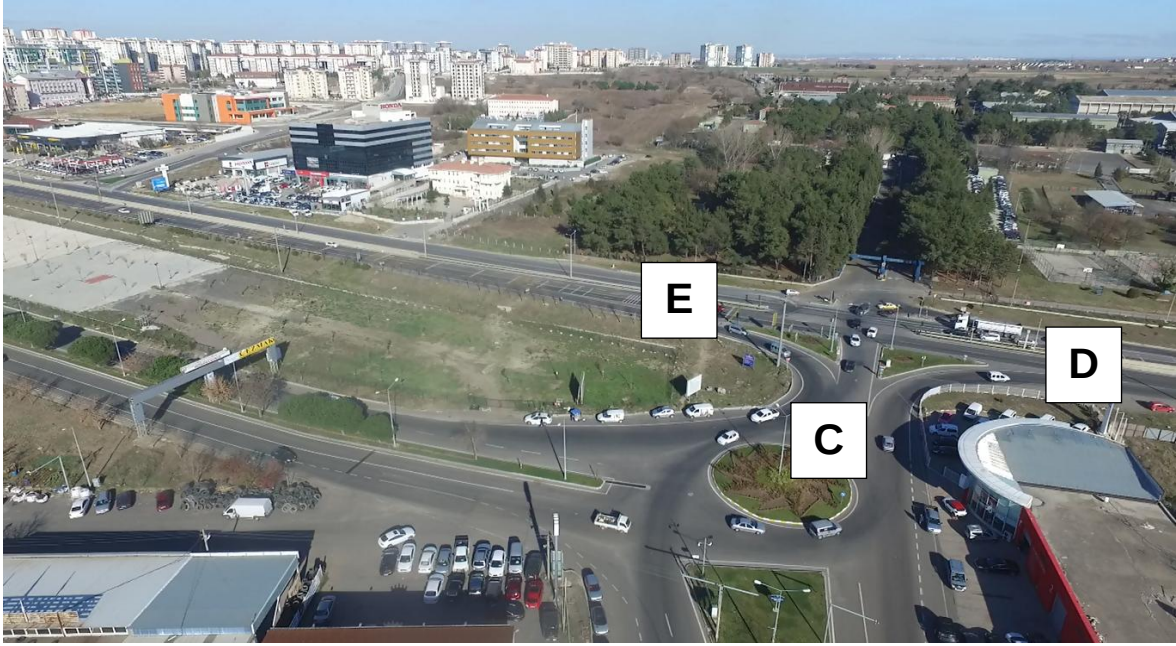
Şekil 1.7. 5-2 No'lu kavşak İHA görüntüsü ve kollar
