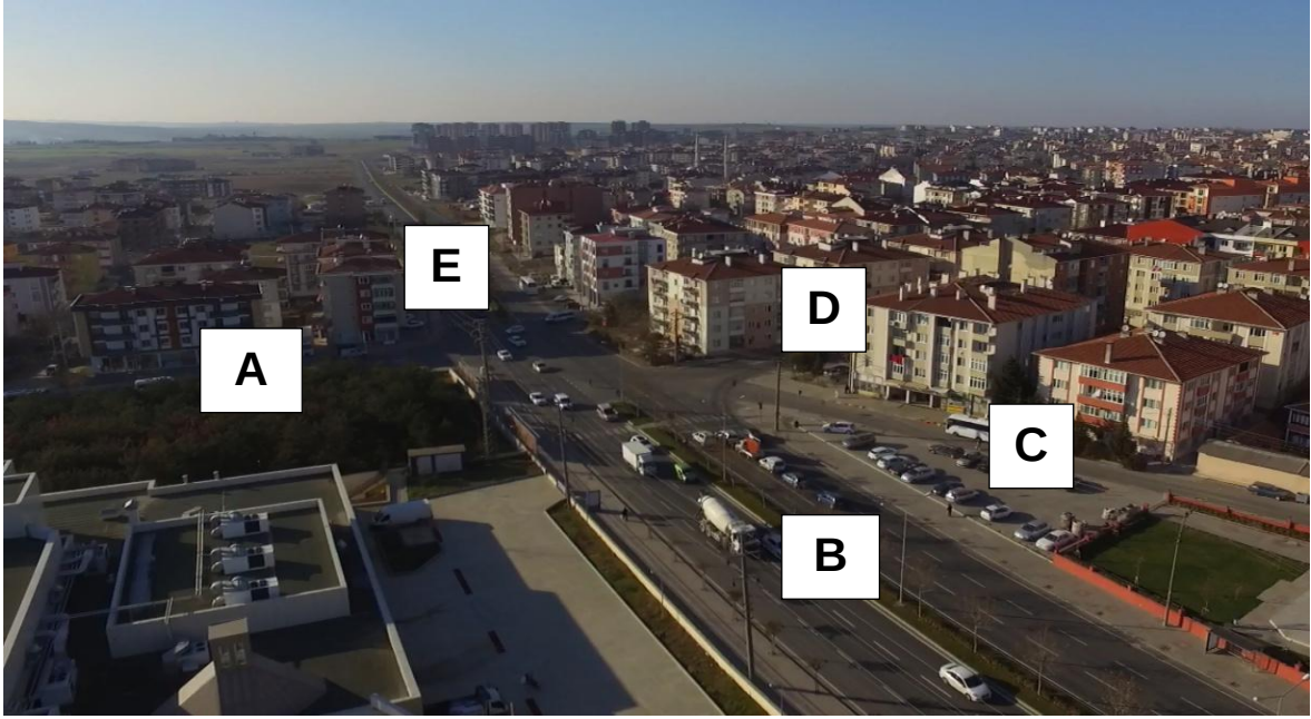
Şekil 1.24. 22 No'lu kavşak İHA görüntüsü ve kollar
