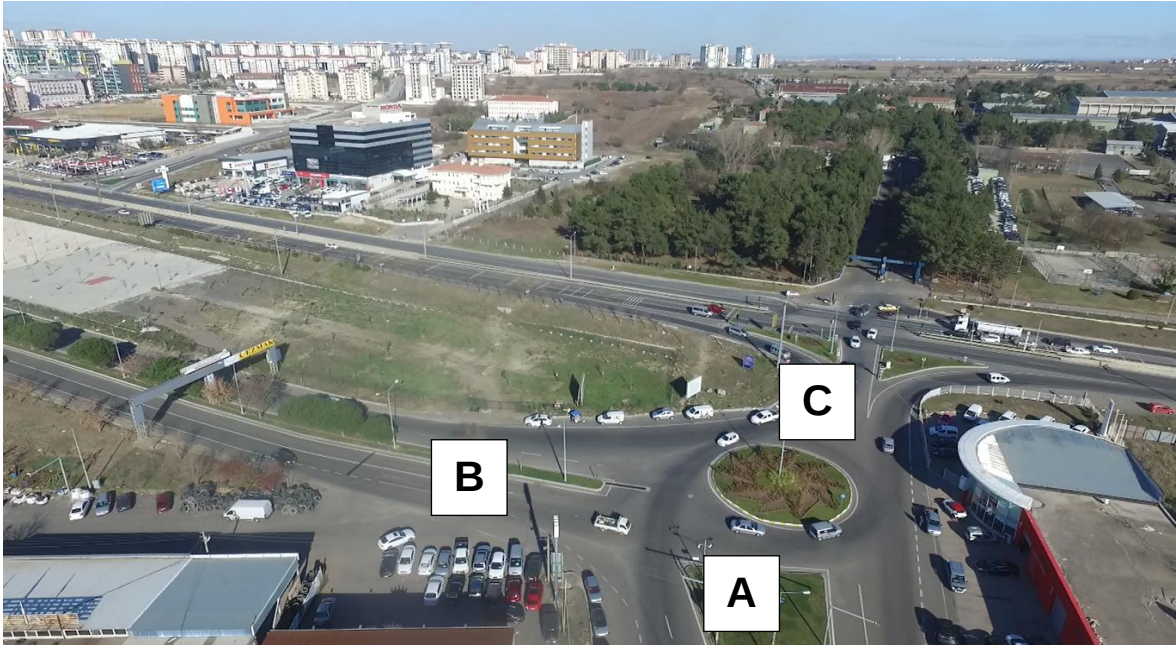
Şekil 1.8. 5-3 No'lu kavşak İHA görüntüsü ve kollar
