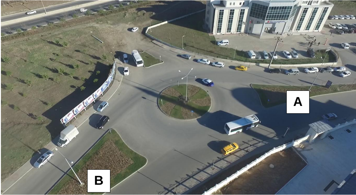
Şekil 1.2. No'lu kavşak İHA görüntüsü ve kollar
