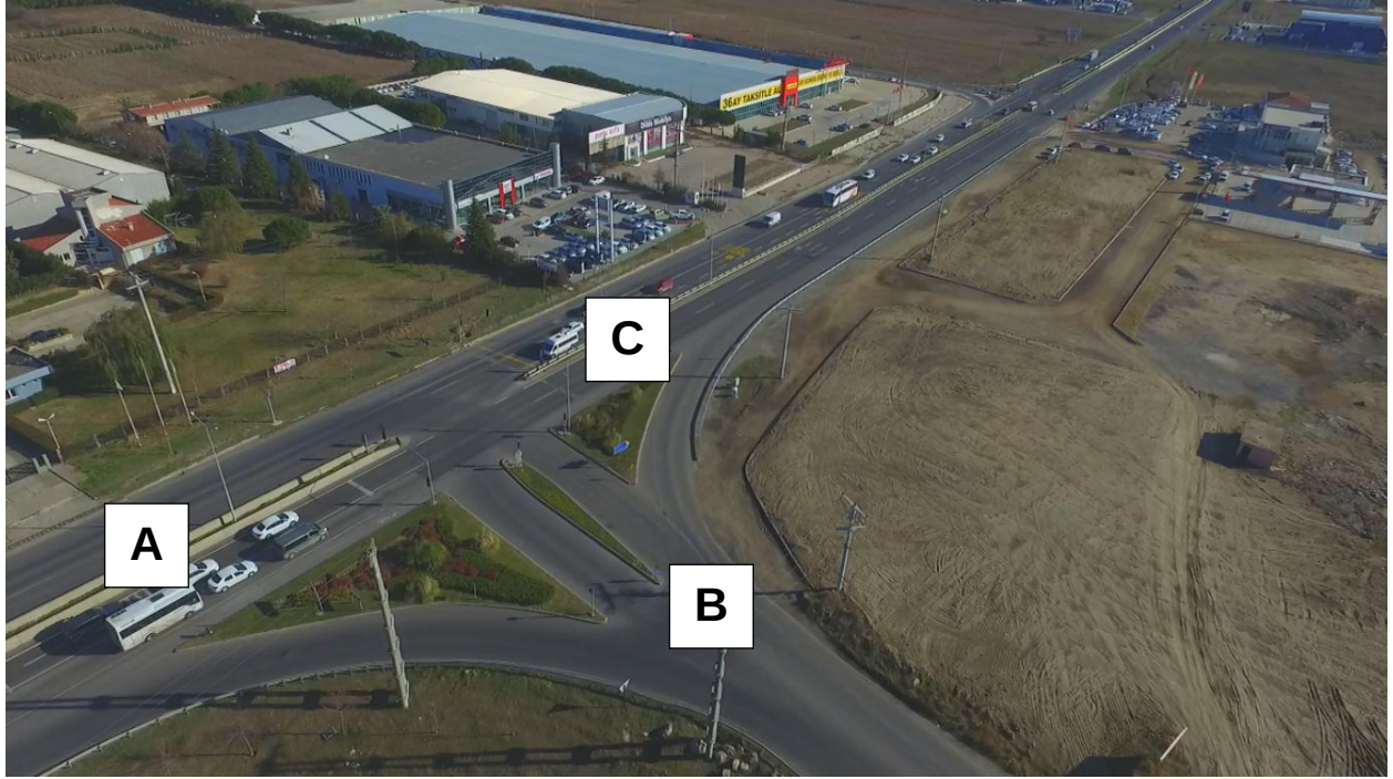
Şekil 1.10. 7-1 No'lu kavşak İHA görüntüsü ve kollar
