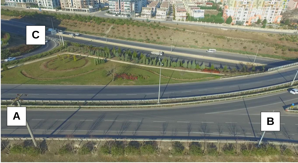
Şekil 1.9. 6 No'lu kavşak İHA görüntüsü ve kollar
