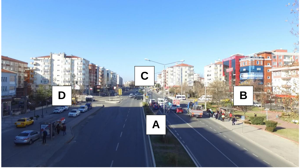
Şekil 1.21. 19 No'lu kavşak İHA görüntüsü ve kollar
