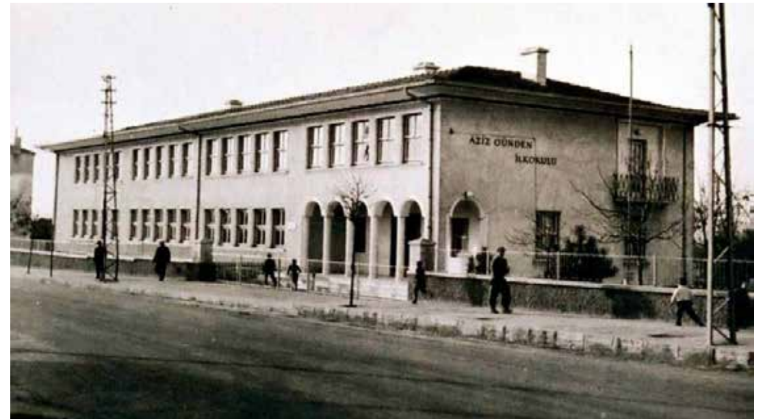
Okul binası, 1960'lı yıllar
