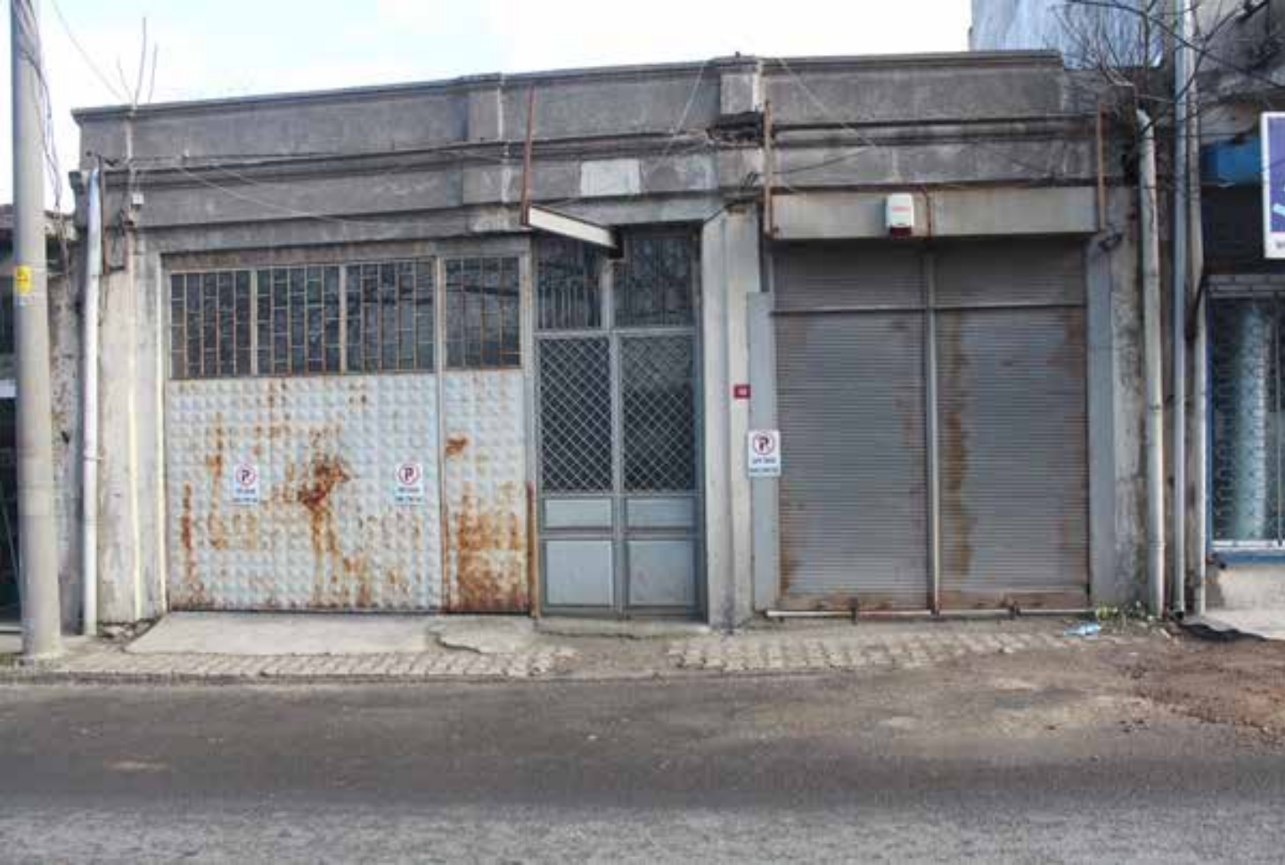
110 ada 10 parsel > Kagir Ticarethane [Hıdırağa Mah.]
