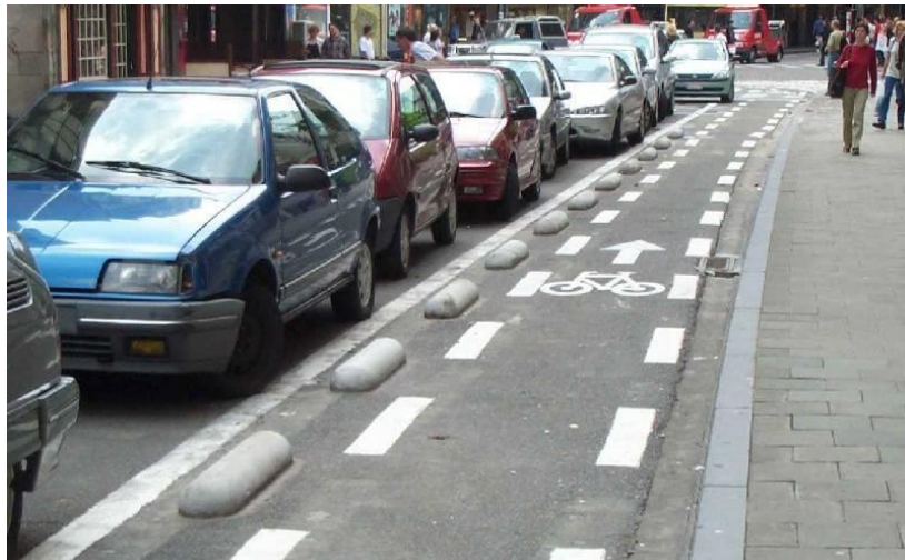
Fotoğraf-8.3 Fiziksel Engelle Ayrılmış Bisiklet Şeridi
