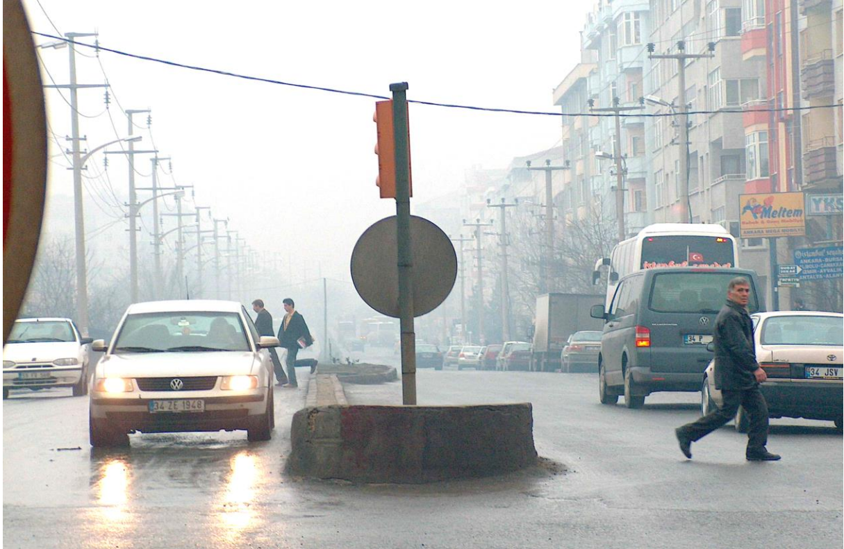
Foto-2.4.18 Standart Dışı Kavşak Düzenlemesi
