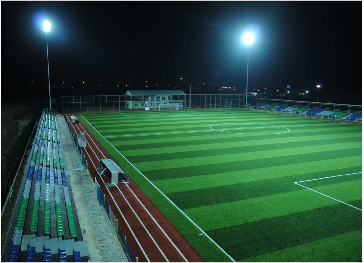
ÇORLU BELEDİYESİ ŞEHİR STADI
